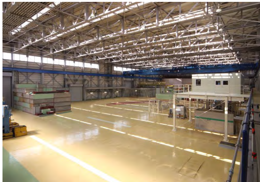
改修・整備後
