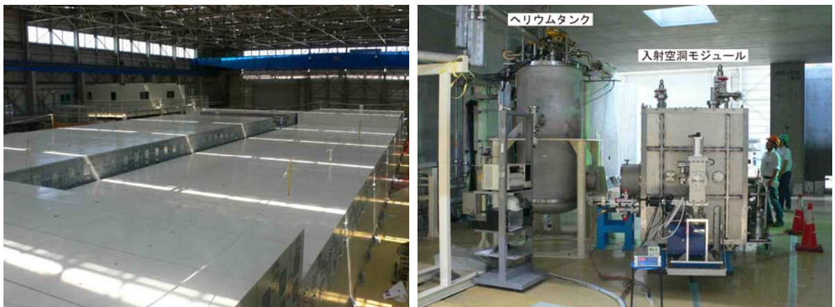
図 2 : ERL 開発棟内で建設が進むコンクリート製の cERL 用放射線シールド (左の写真) とシールド内の入射器ビームラインに設置された入射器用超伝導空洞モジュール及び 2K 液体ヘリウムタンク (右の写真)。
