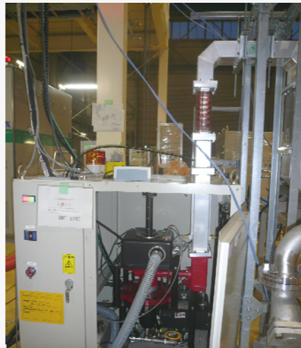
主空洞用30kW IOT
