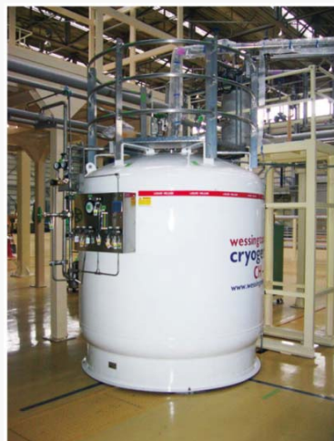
3000L 液化ヘリウム貯槽
