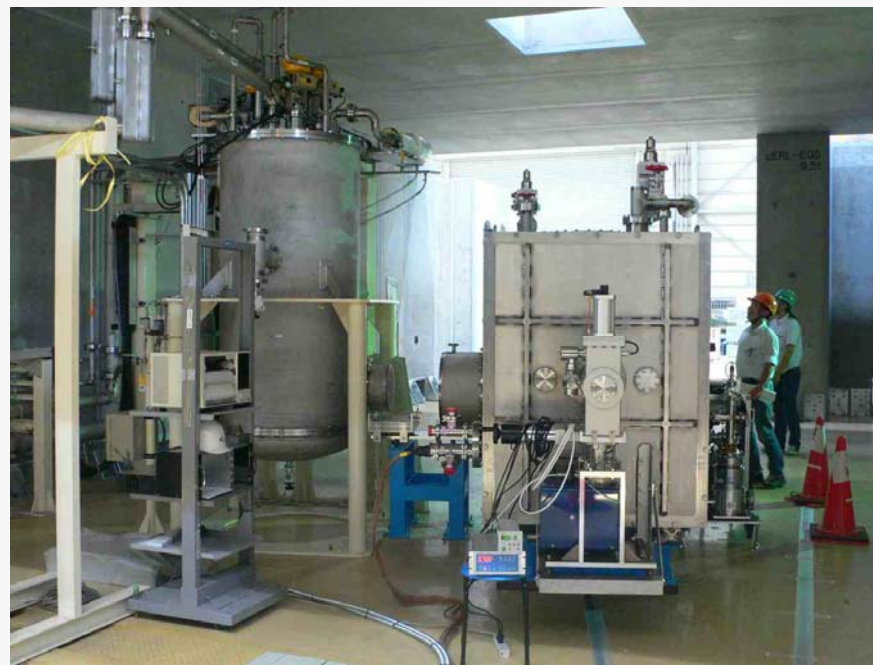
ヘリウムコールドボックス(左)と入射空洞モジュール(右)
