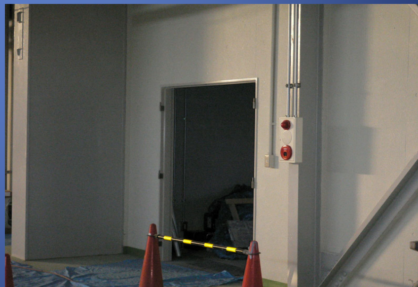
塗装工事及非常停止設置
