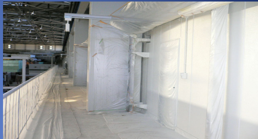
壁の塗装工事
