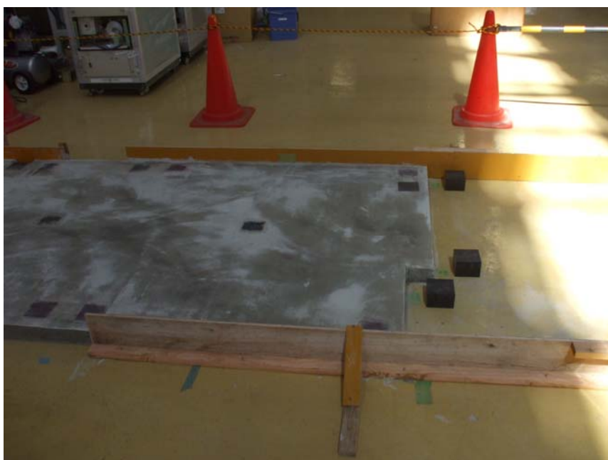
鉄板シムとモルタルで高さ調整
