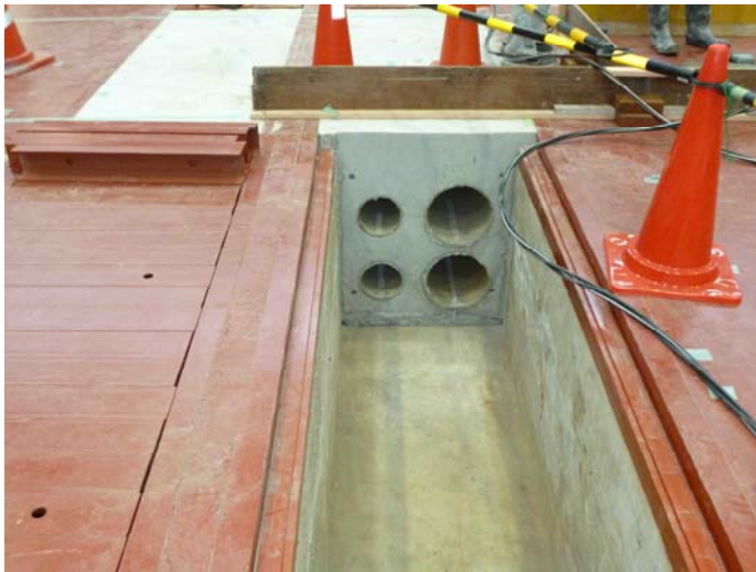
必要な所には、埋めたピットに貫通孔を準備 (冷却水や排水管用)
