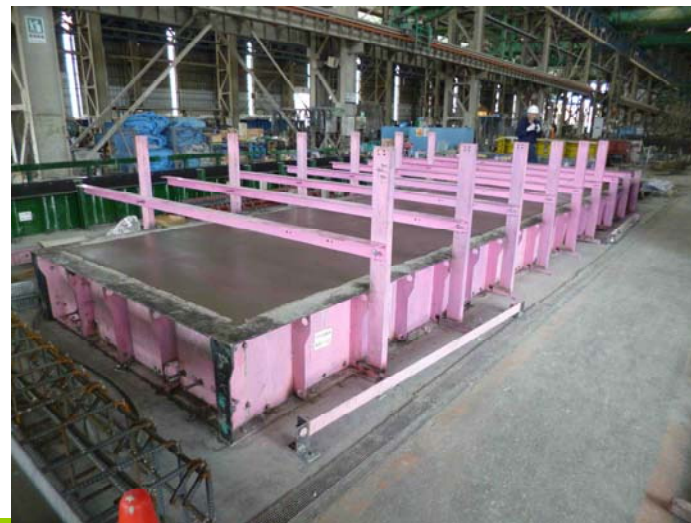
型枠に入れてコンクリートを流し込む
