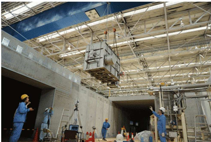
入射部空洞の現場設置
