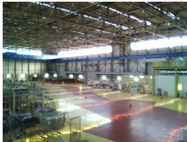
放射線シールド建設状況
