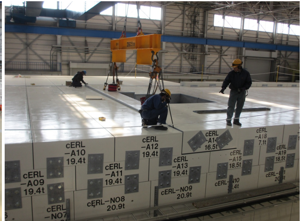
最後のシールドブロック(天井蓋)設置作業(12月7日)
