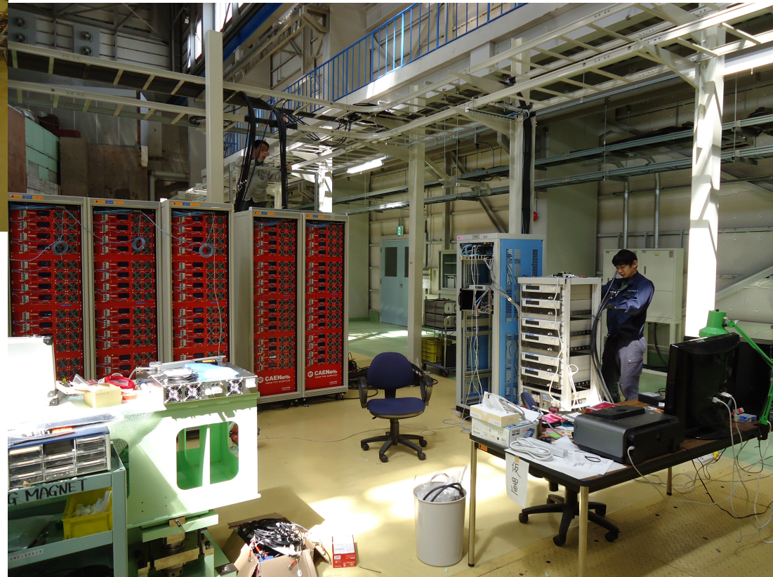
電源側配線中
