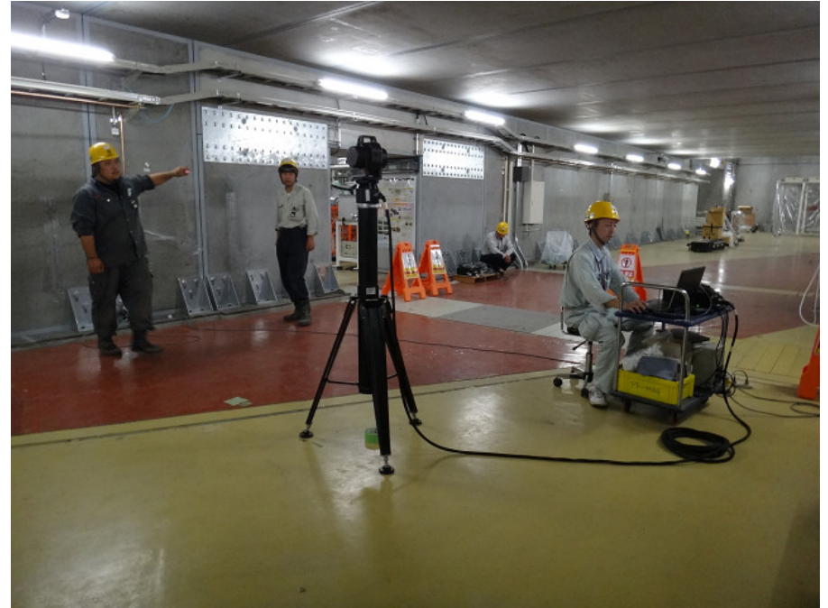
レーザトラッカによる精密測量
