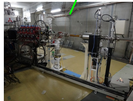
交差点付近の仮配管
