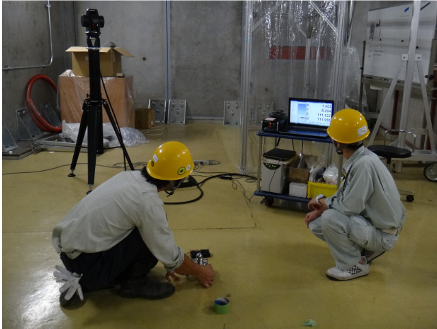
レーザトラッカによる 床面基準点位置出し
