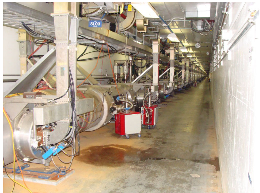
南直線部地下
