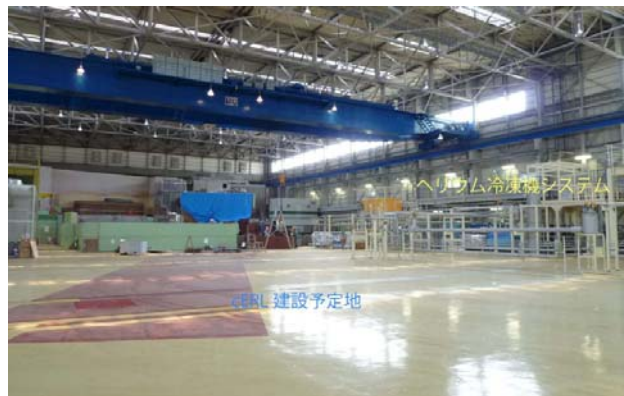
図 4： 改修後の東カウンターホール内部
