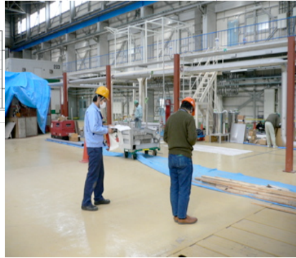
シールド位置確認作業
