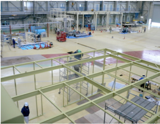
ビニールハット工事
