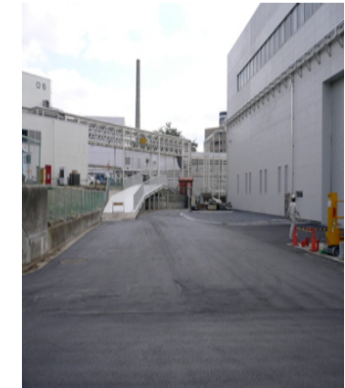
東面舗装及び塗装完了
