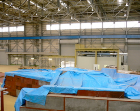
EP2部撤去作業
