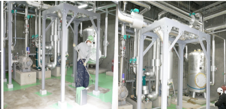
機械室床の塗装 配管等の保温作業
