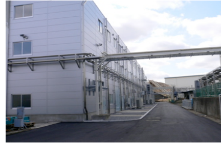
北面舗装・塗装・空調機調整完了
