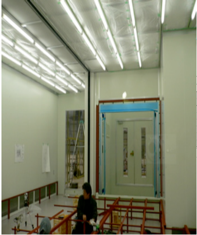
クリーンルーム工事
