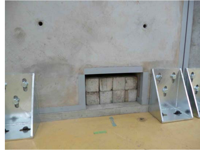
遮蔽体の貫通孔を遮蔽材で埋めてみる
