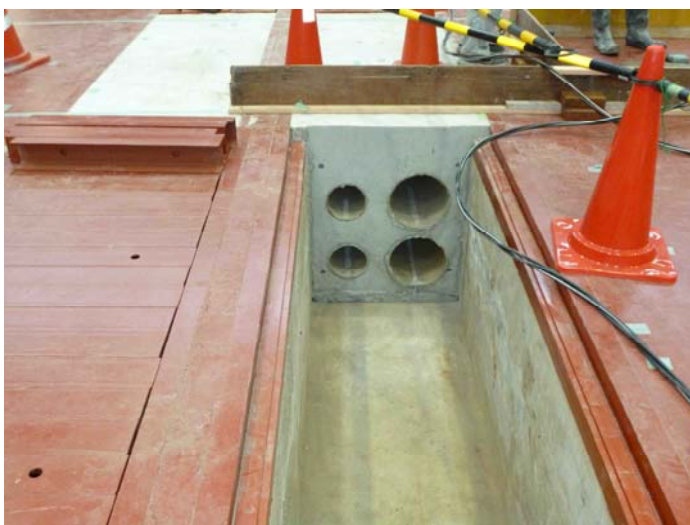
必要な所には、埋めたピットに貫通孔を準備 (冷却水や排水管用)
