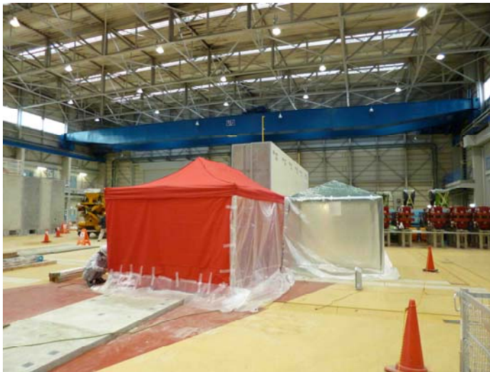
放射化している床面への加工作業 (グリーンハウスを設け、 タイベックススーツ着用 移動時には床面のスミア検査実施)
