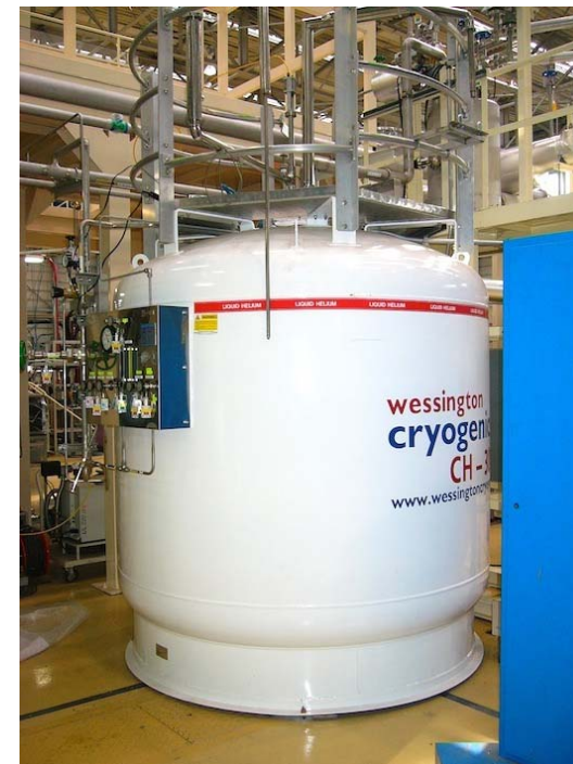
3000L液化ヘリウム貯槽
