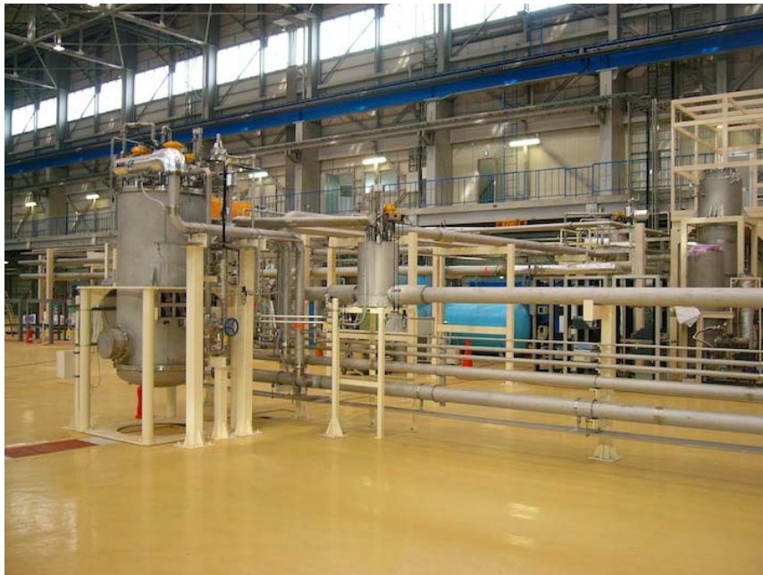
トランスファーラインと2Kコールドボックス
