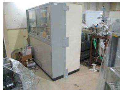
写真13, 14, 15 金具を使い、床にアンカーボルトで固定したラックと書庫
