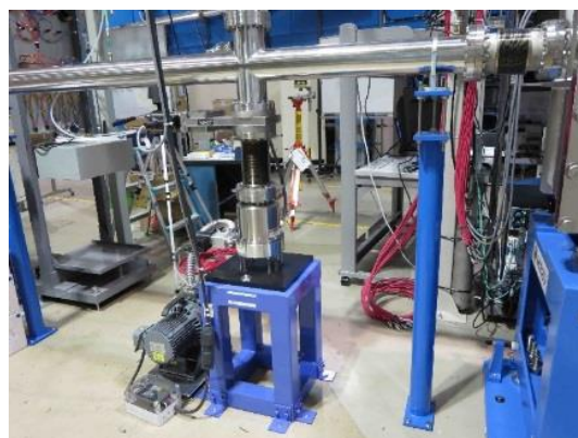
写真 5 真空ステーション ポンプは除振台、砂入架台の上に設置
