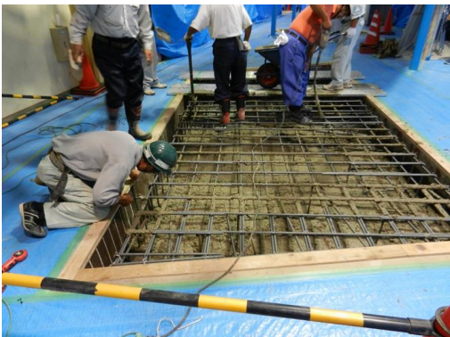
図4：配筋とコンクリート打設の様子
