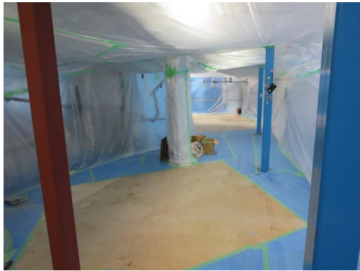
図2：工事現場 テントを張った様子
