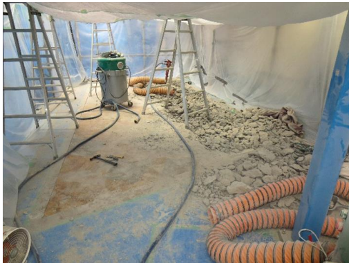
図3：コンクリート床撤去の様子
