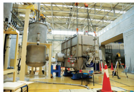
ERL開発棟に設置される前段加速器用超伝導加速空洞
