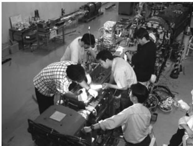
図2 セプタム電磁石更新作業
