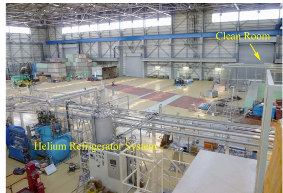
写真1 ERL 開発棟で建設中の cERL
