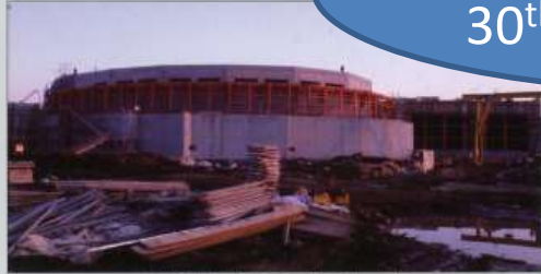
1980年12月 建設中のフォノンファクトリー光源棟
