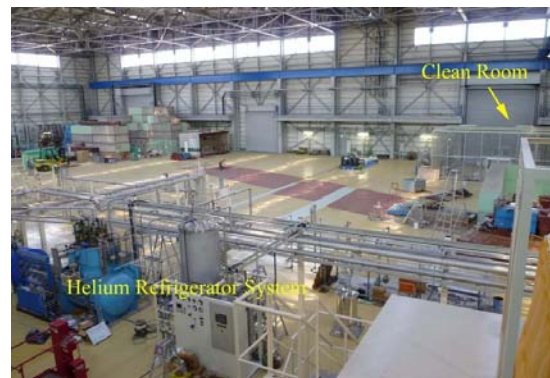
写真1 ERL開発棟で建設中のcERL
