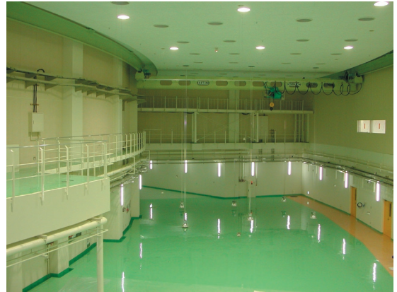
写真 3) 北西実験棟内部 (3 月上旬)
