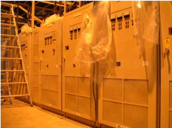
主4極電磁石用大型電源
