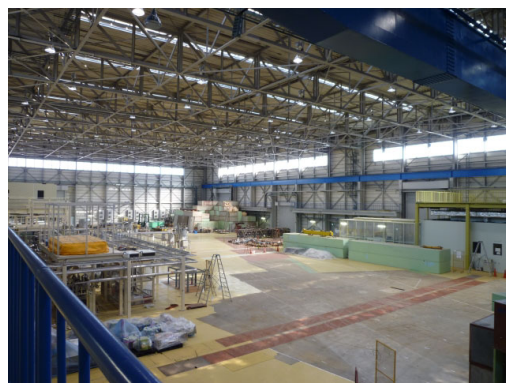
図2 整備が進む東カウンターホール
