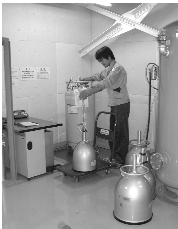
写真4 液体窒素汲出し室
