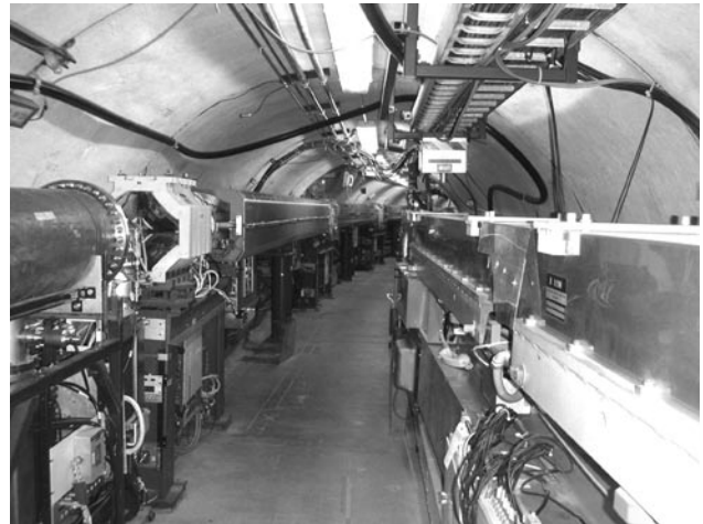
図1 CESR トンネルの内部。内側に入射用シンクロトロン、外側に CESR リングの 2 つの加速器が設置されている。
