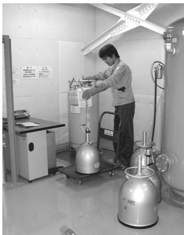
写真4 液体窒素汲出し室
