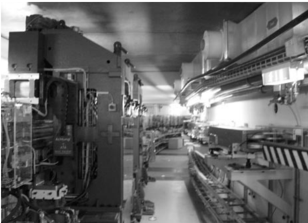
図3. SLSのリングトンネル内。右にあるのがブースター(トラジの)、左は挿入光源、右上は空調ダクト。
