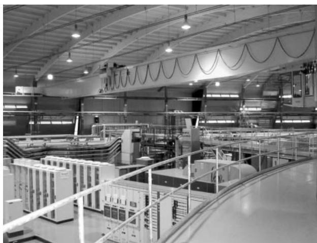
図2. SLS のオフィス廊下からリング、実験ホール方向を見る。手前は電源類、その奥にリングがあり、その先に実験ホールがある。
