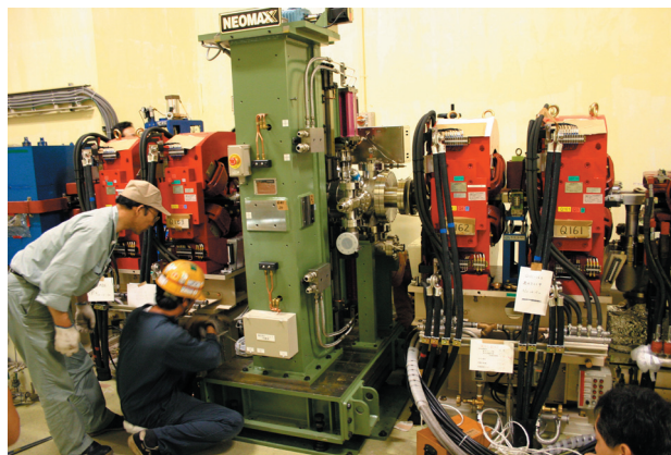
写真3 B16-B17間の短直線部への短周期アンジュレータ#17の設置作業。
