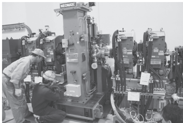
写真3 B16-B17 間の短直線部への短周期アンジュレータ #17 の設置作業。
