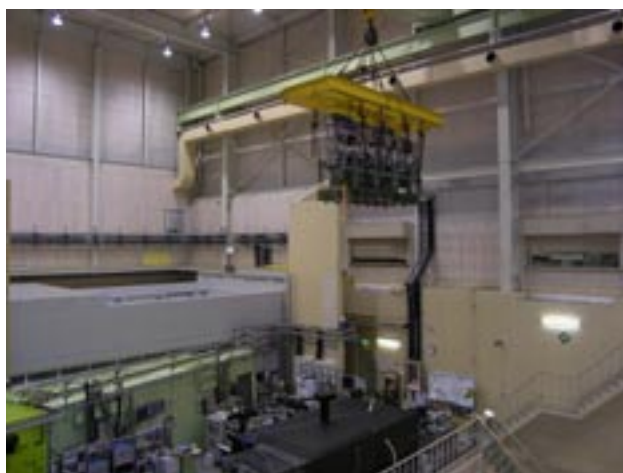
写真2 クレーンに宙吊りで運ばれるアンジュレータ
