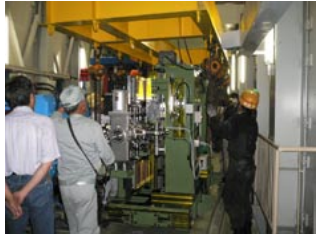
搬入作業中のNW14用真空封止アンジュレータ
