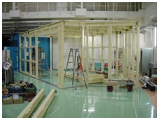
写真1 建設中の実験ハッチ
