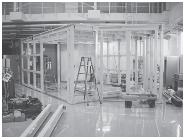
写真1 建設中の実験ハッチ
