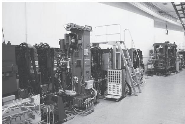
図1 立上直前の PF リング。はしごの手前の角柱が短周期アンジュレータ #17、写真奥に見えるのが MPW#16 と延長された直線部。
