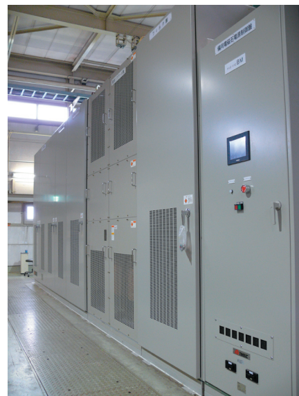
図 1 新しい PF-AR 偏向電磁石電源。
