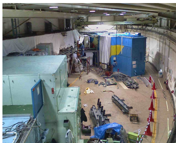
改造作業の様子 (上：3月10日，下：4月18日撮影)
