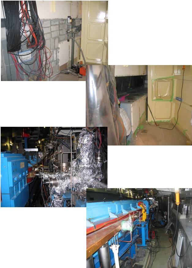
写真1 改造作業の様子 (上段: シールド壁撤去前後、下段: 旧基幹部撤去前後)。
