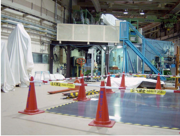
写真2 NE7 建設へ向けて、ほぼ撤去された IT-4。手前の柵内はプレス設置のために床を掘り下げたところ。
