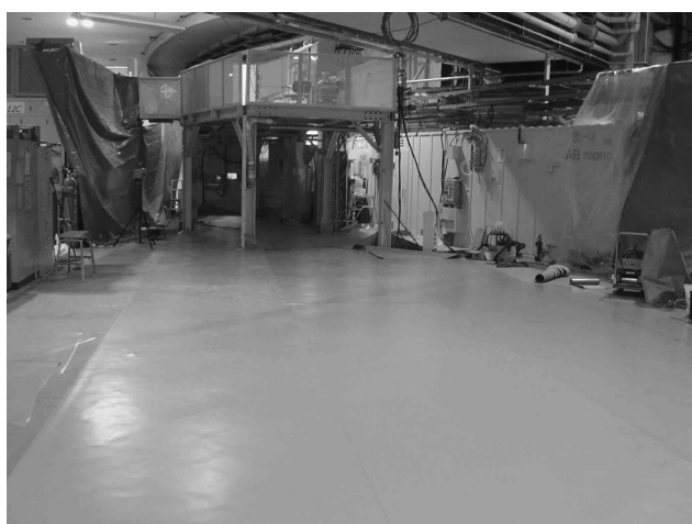
図2 既設のBL-13A, 13B, 13Cラインが撤去されたBL-13。左はBL-12, 右はBL-14ビームライン。
