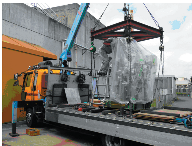
図 1 PF リング搬入口前での SGU#01 の積み降ろし作業。
