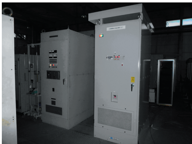
図3 PF-AR の新4極電磁石電源(右側)を示す。今回の4極電磁石電源の更新は、全20台の中の最大容量のQF電源1台のみであった。左側の電源は、既設4極電磁石(QD)電源である。
