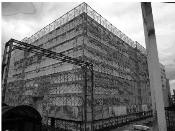
図2 東カウンターホールの外壁断熱工事(8月末頃に撮影)。
