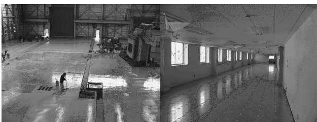
図4 東カウンターホール内の状況（12月撮影）
