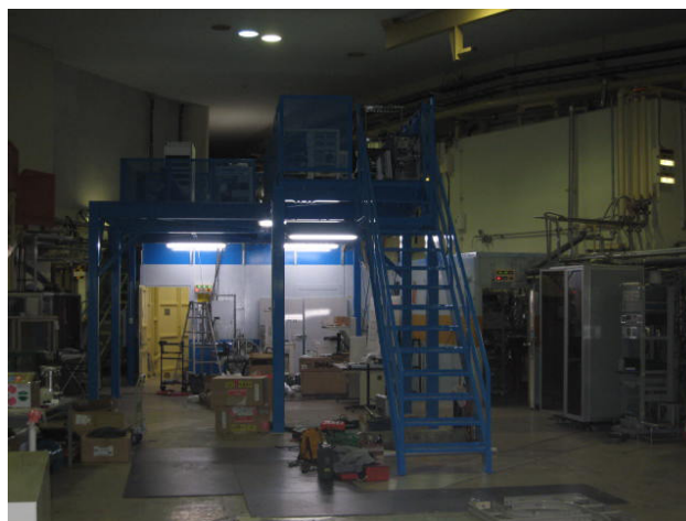
図1 建設されたBL-1中二階デッキ
