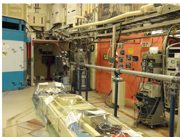
図2 撤去された旧BL-6A実験ハッチ
