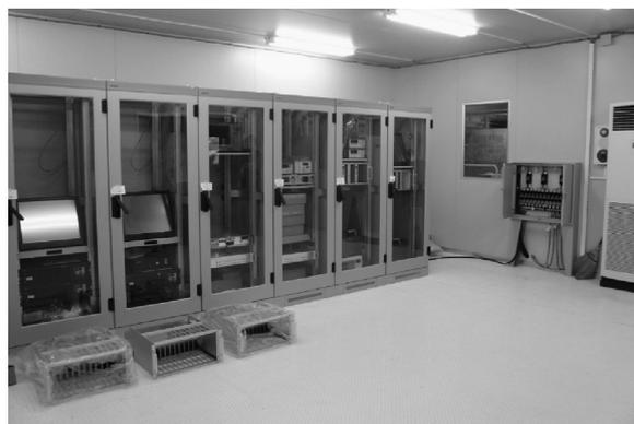
図 4 LLRF の制御室に設置されたモジュールを搭載するラック・スタンド
