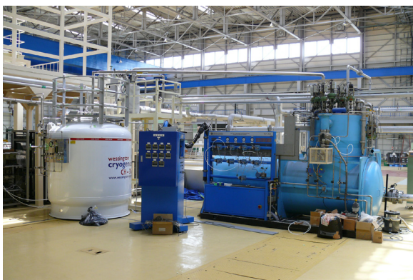
図2 物質・材料研究機構から譲り受けたヘリウム冷凍機とバッファータンク
