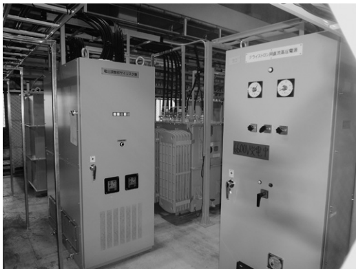
図1 PF電源棟に設置された新RF高圧電源
