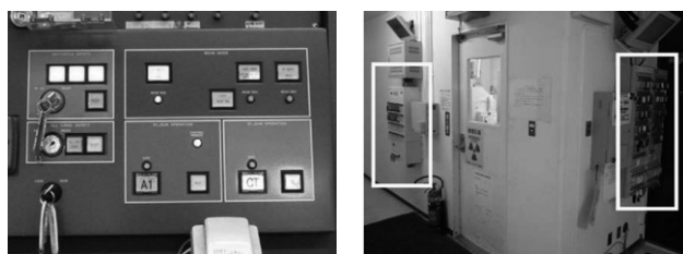
図2 (写真左)入射器制御卓。左上のエリアがセクタ3~5運転用3T電子銃ビームキー。その下のエリアが入射器全体運転用A1電子銃ビームキー。(写真右)加速器トンネル入室用個人キーボックス。左側枠内が全トンネル入室用、右側枠内がセクタA~2トンネル入室用。
