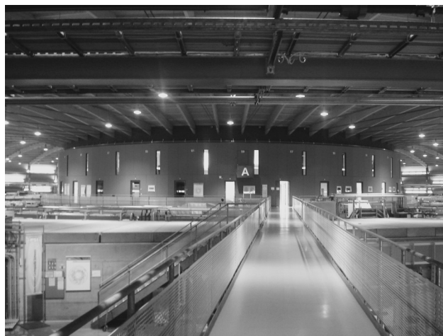
図1 SLS内部。中央の筒は内部スタッフ居住棟。手前のコンクリート壁の中にストレージリングがある。
