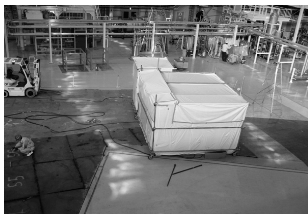
図5 旧ビームラインの上流部に敷かれていた、放射化した鉄板およびモルタルの除去作業の様子。
