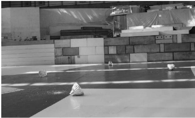
図 1 地震の衝撃で落下した ERL 開発棟の照明
