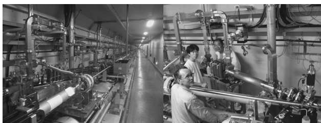
図 1 (左) 夏期保守後の入射器 3~5 セクター (右) 3 セクター上流への試験用 RF 電子銃の設置作業風景。
