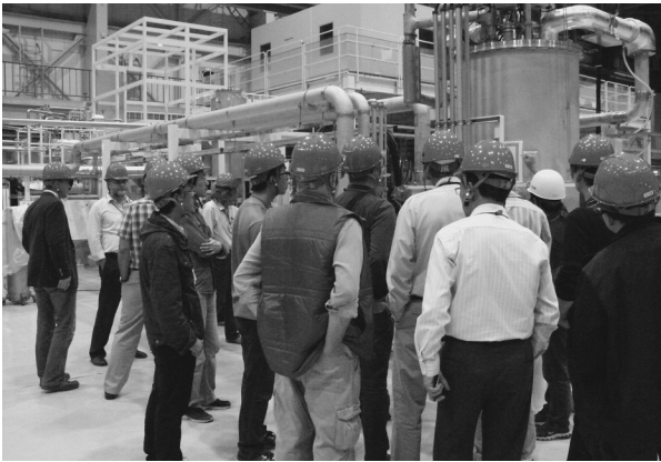
cERL 建設現場（ERL 開発棟）を見学する参加者たち
