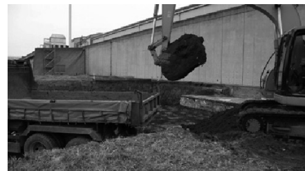
図9 12月に始まったダンピングリング土木工事
